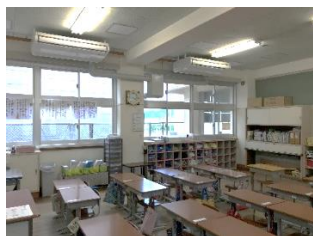
【空調・換気設備を備えた教室】
